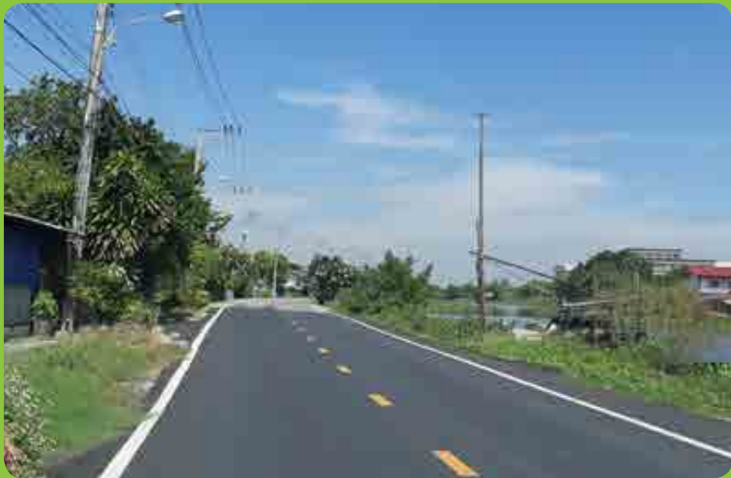
ซ่อมแซมถนน คสล. สายคลองลำโรง-บ้านคลองเสาระหงษ์ หมู่ที่ ๑,๒,๓ ตำบลศิระจรเข้ใหญ่ อำเภอบางเสาธง
