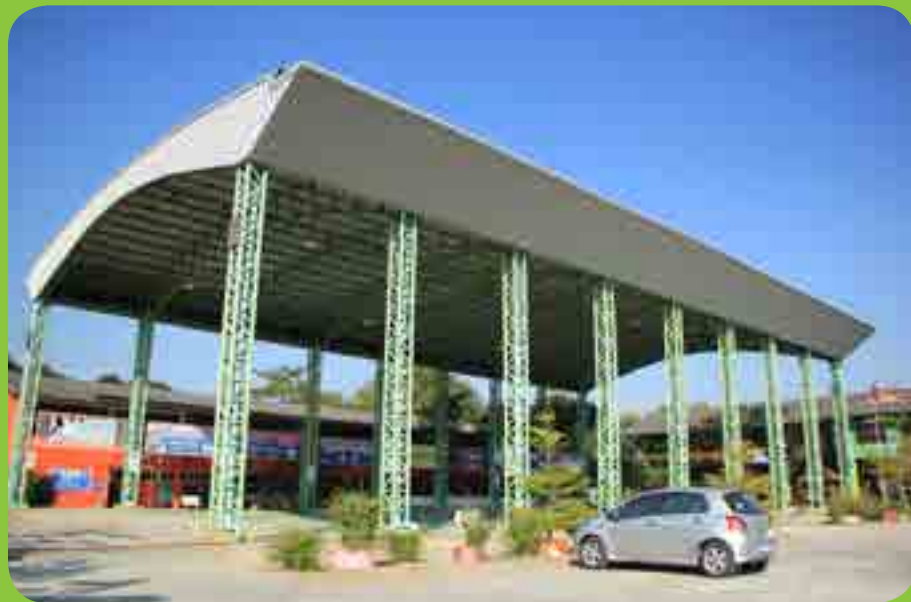
โครงการก่อสร้างหลังคาเมทัลชีท โรงเรียนบ้านทองคูง
