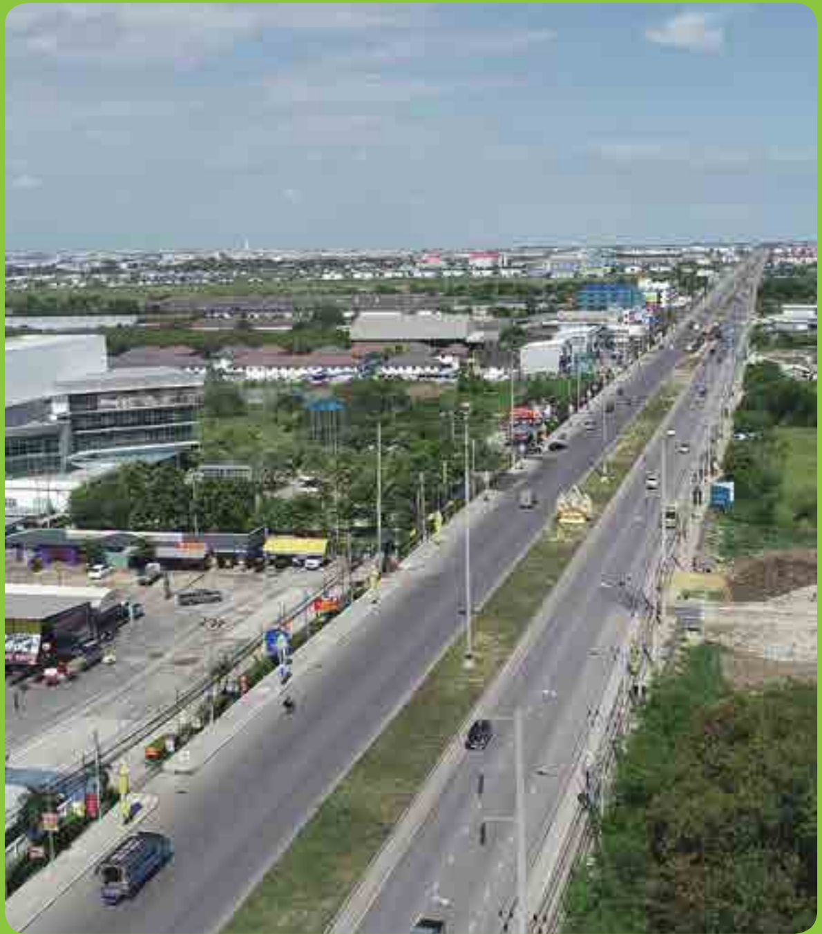
โครงการก่อสร้างและขยายถนนทางหลวงหมายเลข ๓๑๖ (สายบางปะกง-แพรกษา) ฝั่งขวา/ฝั่งซ้าย ต.แพรกษา อ.เมืองฯ
